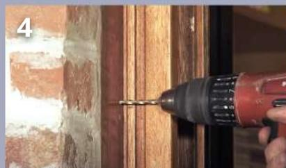
4 Après avoir repéré l'emplacement des trous de fixation des glissières, percer les murs, puis fixer le volet en place.
