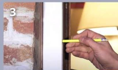
3 **Dans le cas de la pose C :** les glissières ne sont pas percées, il faut donc les percer avec une mèche à métaux ou bois (3 à 4 trous sur la hauteur). Utiliser des fixations (vis, chevilles) adaptées au matériau de construction.
