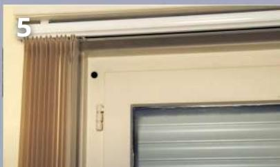
5 Percer le trou de passage du câble d'alimentation du moteur en face de la sortie de câble sur le volet. Passer le câble et fixer le volet roulant dans les murs.
