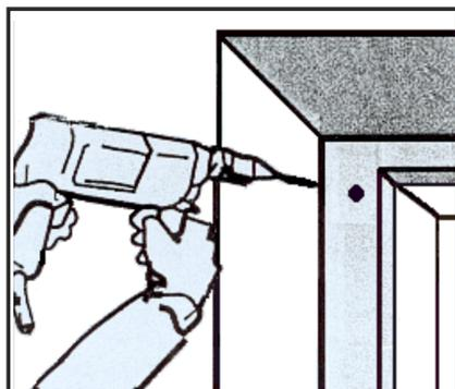
Perçer le trou de passage du câble d'alimentation du moteur en face de la sortie de câble sur le volet.
