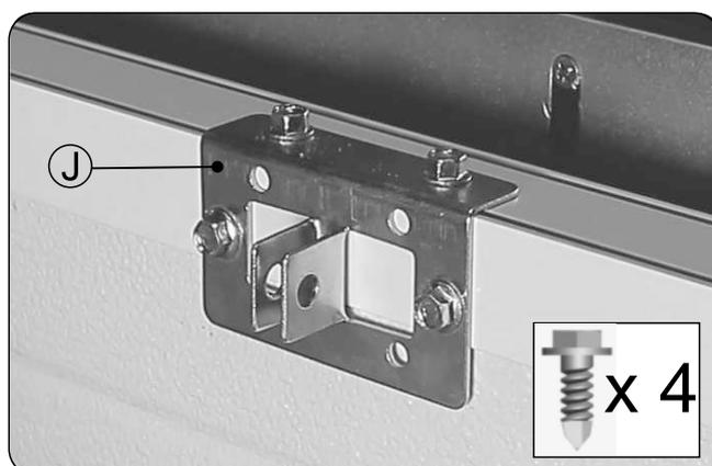
Fixer le support **J** sur le panneau haut au moyen de 4 vis auto foreuses fournies, au milieu de la largeur de la porte.
